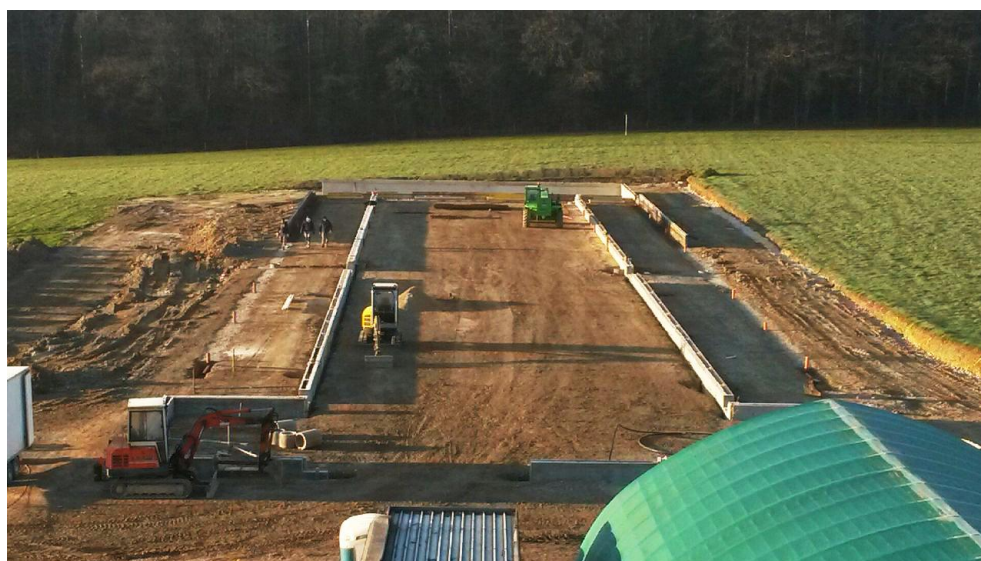
Costruzione del pollaio per 12 000 ovaiole a Céligny
